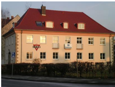
Das Gebäude mit der Fachstelle in der Leuchtbergstraße 10b in Eschwege
