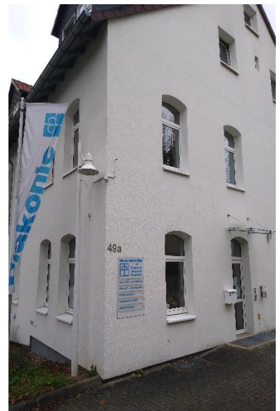
Außenansicht der Außenstelle in Witzenhausen, Walburger Str. 49a.
